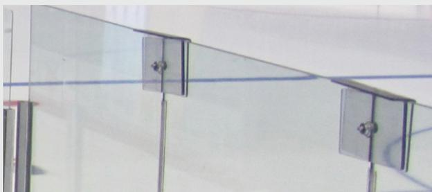
Les attaches pour les baies vitrées permettent à chaque panneau de bouger de façon indépendante sous un impact, ce qui permet de maximiser la flexibilité de tout le système de baie vitrée.
