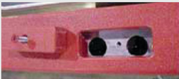
La plaque d'accès située sur la coursoire supérieure de la bande côté spectateur permet un ajustement facile des panneaux de verre sans l'aide de cales.
